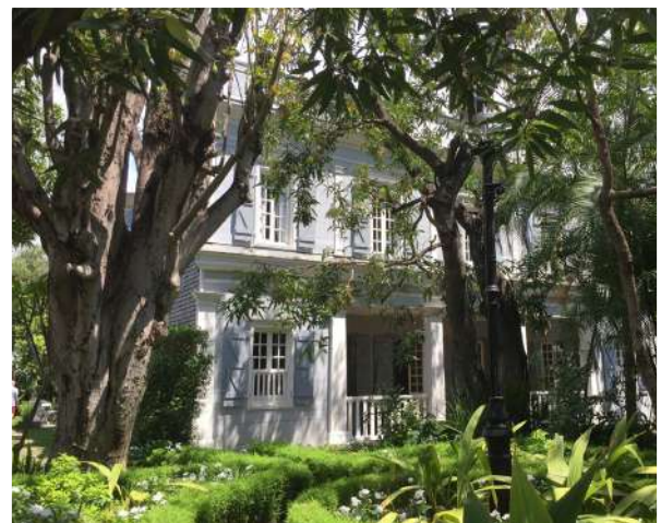
Villa Rivière © Villa Rivière
